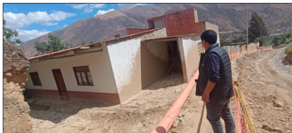
FIGURA N°02: Tramo de la quebrada que presenta un talud inestable con un deslizamiento de tierra y una edificación en riesgo en la parte superior, que presenta signos de afectación en el último desborde.
